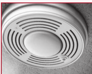
Fire Alarm Upgrade Mejoras de alarma de incendio
