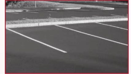
Parking Expansion / Ampliación de aparcamiento
